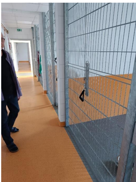
Abbildung 22 Innenbereich mit neuartigem Kautschukboden im Hundehaus
