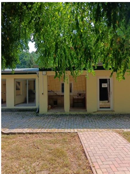
Abbildung 25 Blick zum sanierten Katzenhaus
