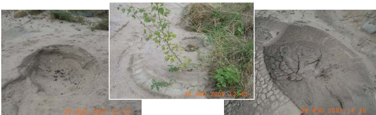
Bild 2 Strudellöcher mit Materialauswurf im Bereich des Rutschungskessels (Aufnahmedatum 28.08.2009)
