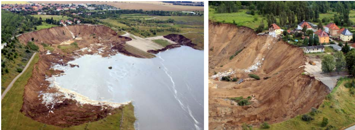
Bild 1 Luftbildaufnahme des Rutschungskessels nach der Böschungsbewegung in Nachterstedt am 18.07.2009 (Befliegung am 18.07.2009) links: Blick aus nordöstlicher Richtung; rechts: Blick aus westlicher Richtung
